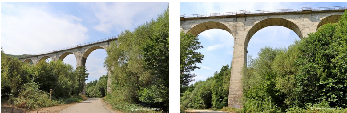
Figure 4. Viaduct Debeli Lug
